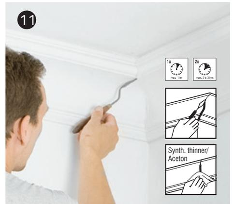
11 Überschüssigen Kleber vor dem Aushärten mit einer Spachtel entfernen durch Abziehen (nach 1 Std und nach 2-3 Std. wiederholen)
