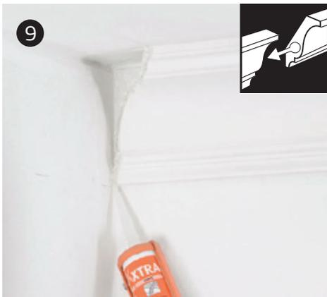
9 Verwenden Sie DecoFix Extra bei jeder Naht. Verwenden Sie Spachtelmasse um die Stoßstellen zu spachteln
