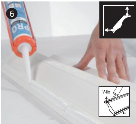
6 Tragen Sie den Kleber in die V-Fugen entlang des Profiles auf
